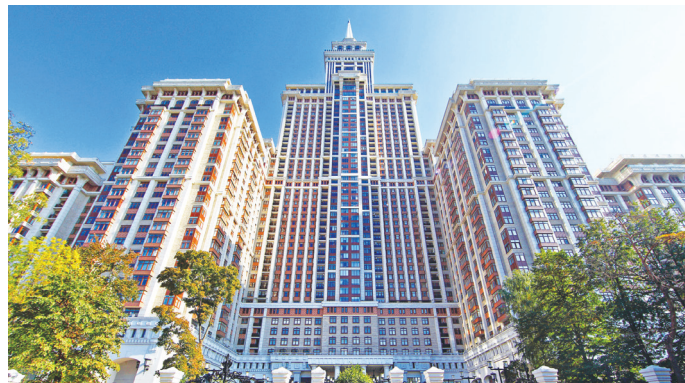
Объект компании: Жилой комплекс «Триумф-Палас» (57 этажей).
