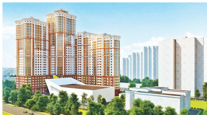
Объект компании: Жилой комплекс «Эмеральд» (21–32 этажа).
