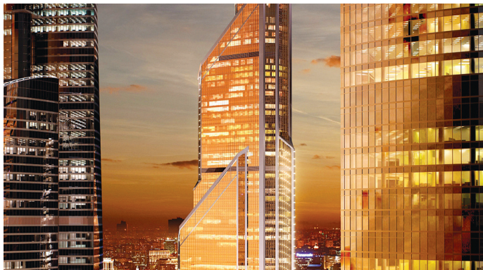
Объект компании: «Меркурий Сити Тауэр», ММДЦ «Москва-Сити» (70 этажей).
